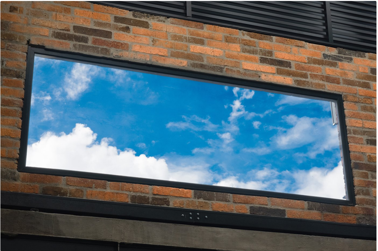
Encuentro fachada-ventana con perfilería metálica integrada y vierteaguas inferior. Detalle bien resuelto que combina sello mecánico y protección hidráulica.
