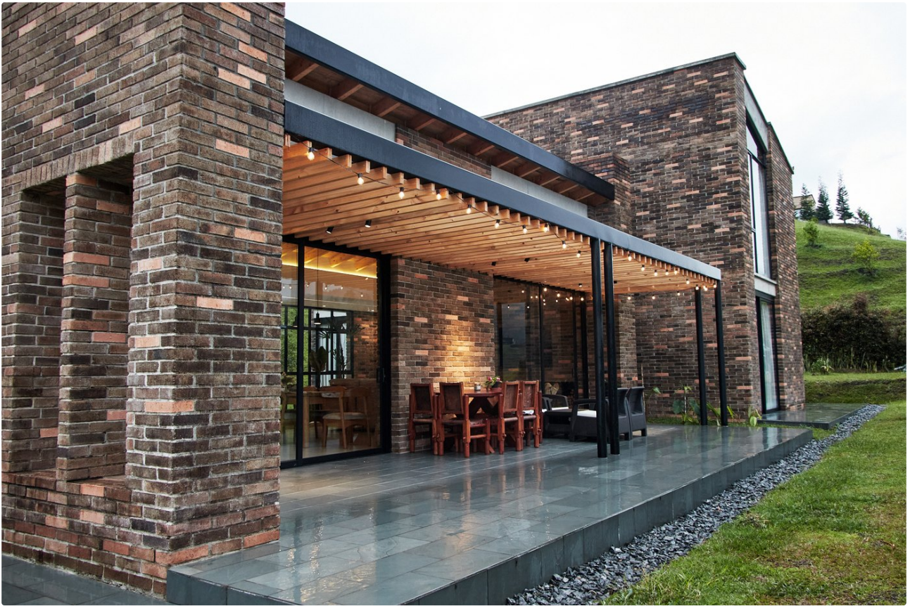
Casa Senderos del Retiro al atardecer — fachada Clayhouse en su mejor luz, después de años de uso y mantenimiento adecuado. La promesa cumplida del manual.
