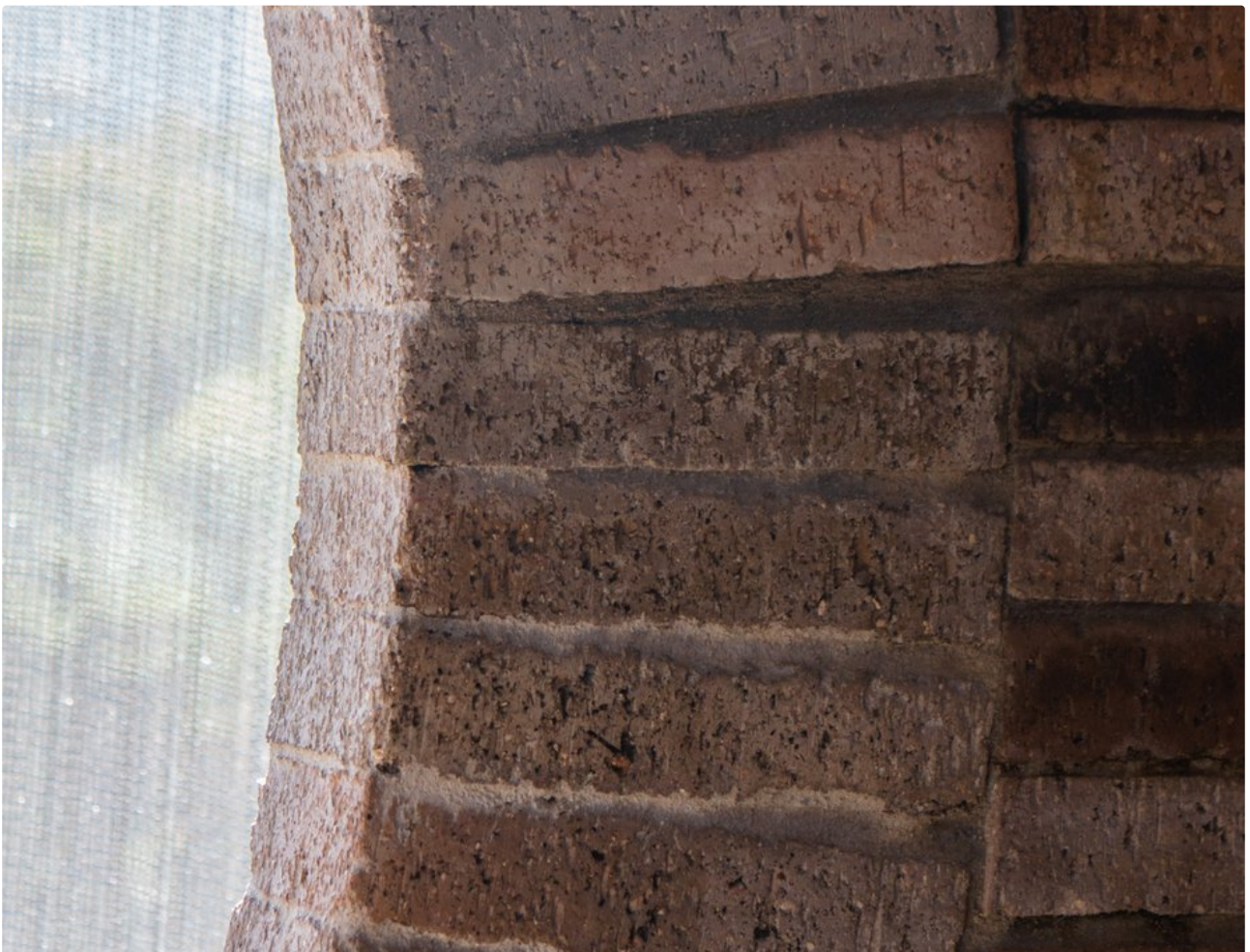
Arco en ladrillo Clayhouse — ejemplo de superficie curva resuelta con piezas trapezoidales y adhesivo flexible. La técnica correcta del arco preserva la estabilidad incluso bajo cargas laterales.
