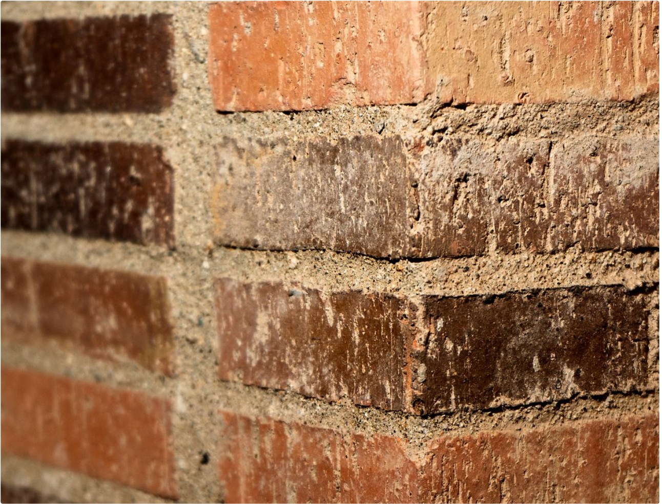
Junta cóncava a ras bien ejecutada en obra Clayhouse — visible en escorzo, con luz lateral. La materialización del diagrama RECOMENDADA: no retiene agua ni suciedad.
