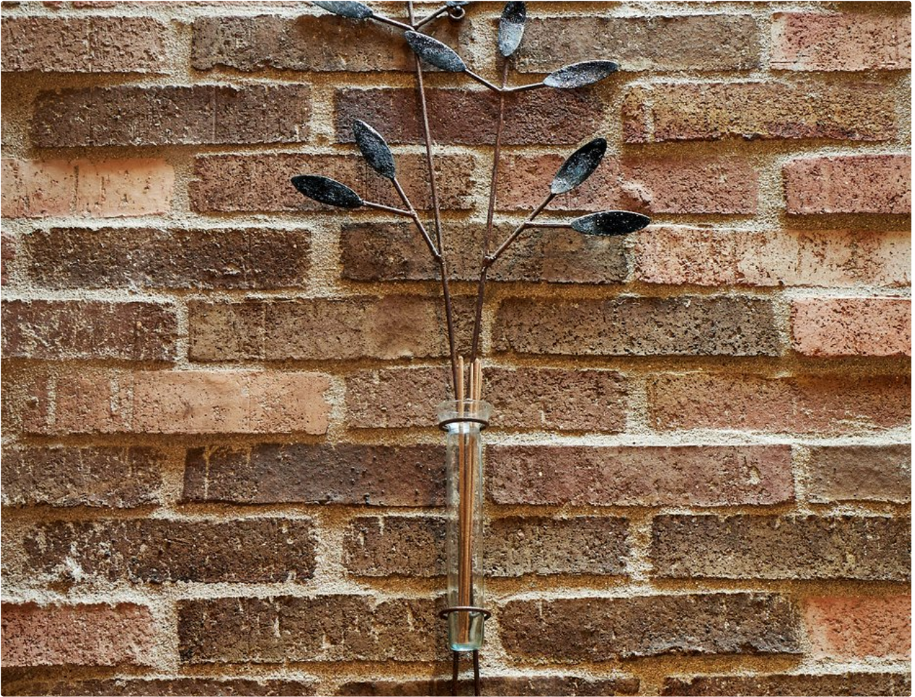
Resultado de un lavado correcto y posterior aplicación de hidrófugo — muro Romano sin veladuras blancas, color natural realzado, junta limpia. El estándar al que apunta el procedimiento de cinco pasos.
