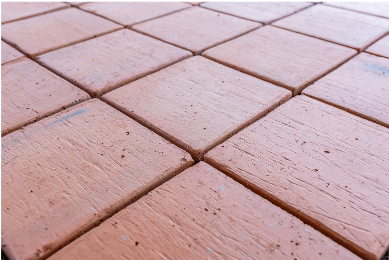
Tablón cuadrado en piso, instalado con junta uniforme de 5 mm. Variación natural de tonos lograda al mezclar piezas de varias cajas.
